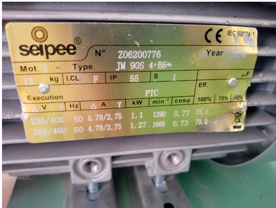
FIGURE 3.2 – Plaque signalétique du moteur asynchrone
