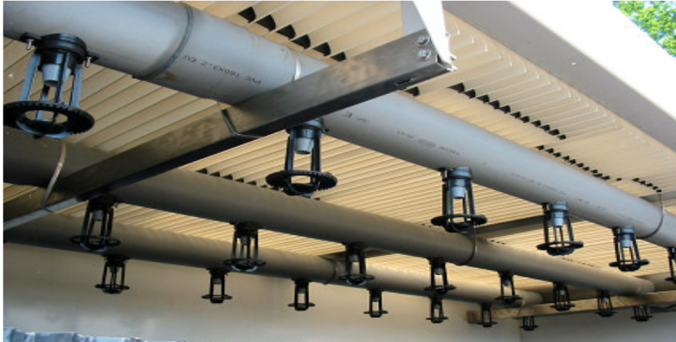
Fig.1.7 : Système de dispersion de l'eau à refroidir [10]
