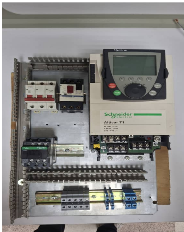
FIGURE 3.18 – Montage des composants de puissance
