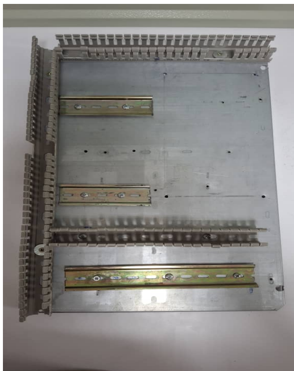
FIGURE 3.17 – Installation des rails DIN et des goulottes
