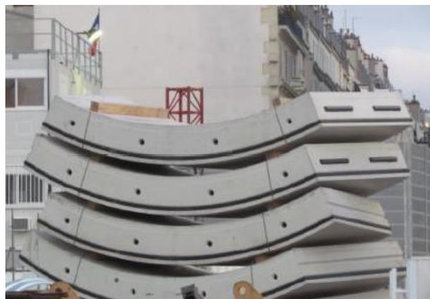
**Figure 2.19- Exemple de voussoirs en béton.** (14)
