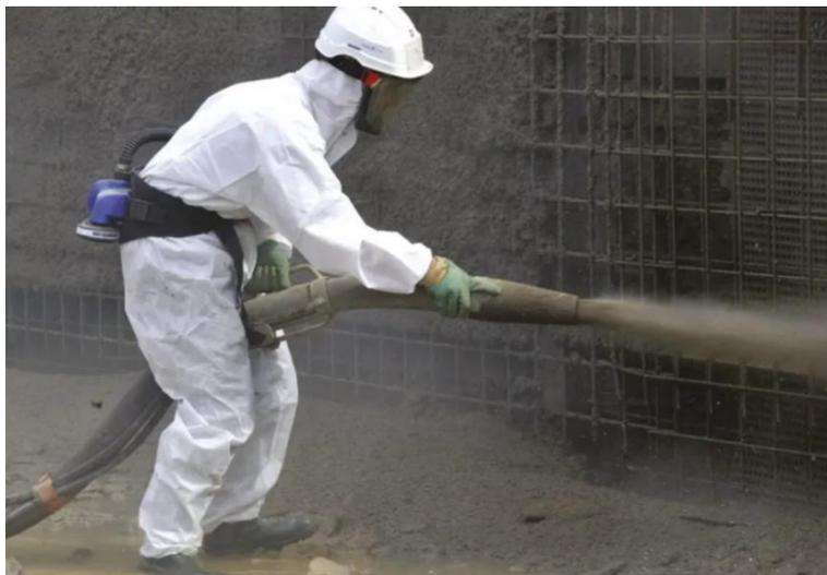
**Figure 2.18- Opérateur de projection en voie humide.** (13)
