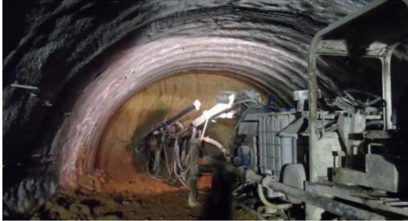
**Figure 2.3- Mise en place du béton projeté. (9)**
