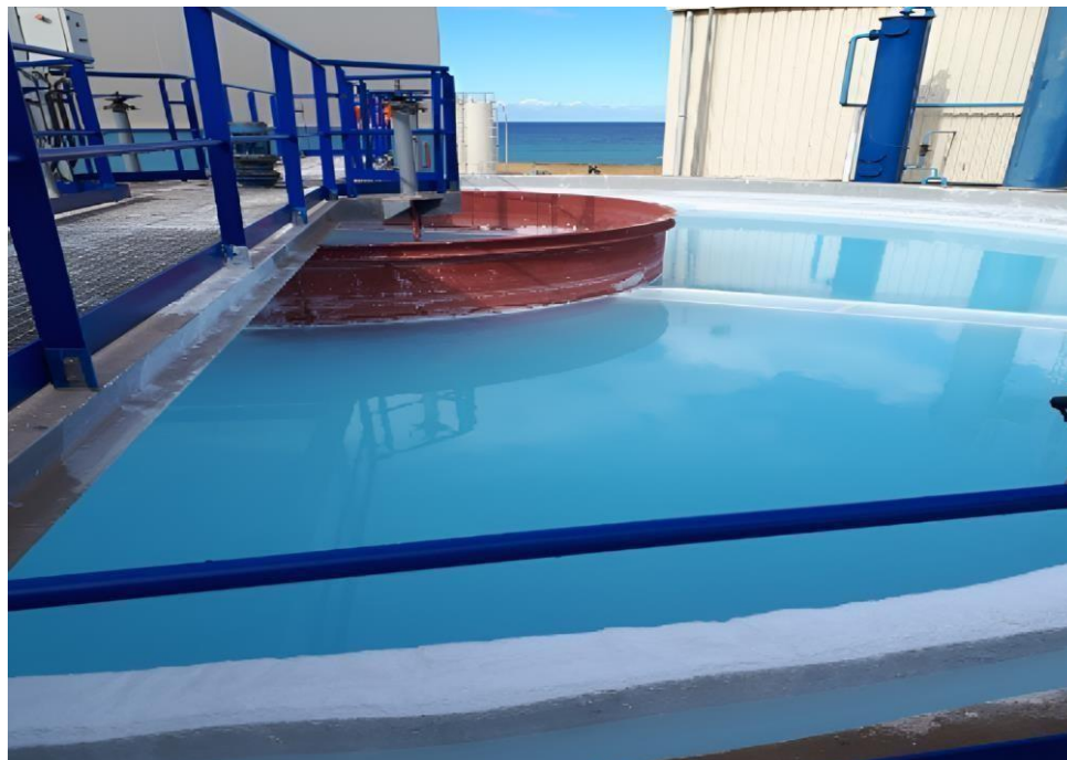
Figure I.13 : photo prise dans la station de dessalement illustrant le saturateur de \text{Ca(OH)}_2 + \text{H}_2\text{O}
