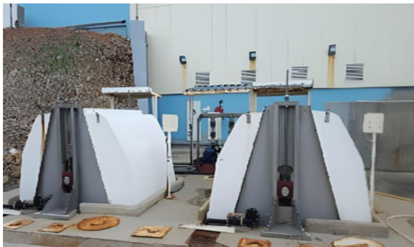
Figure I.6 : photo prise dans la station de dessalement illustrant les deux filtres Beaudry pour la filtration primaire (filtration mécanique)
