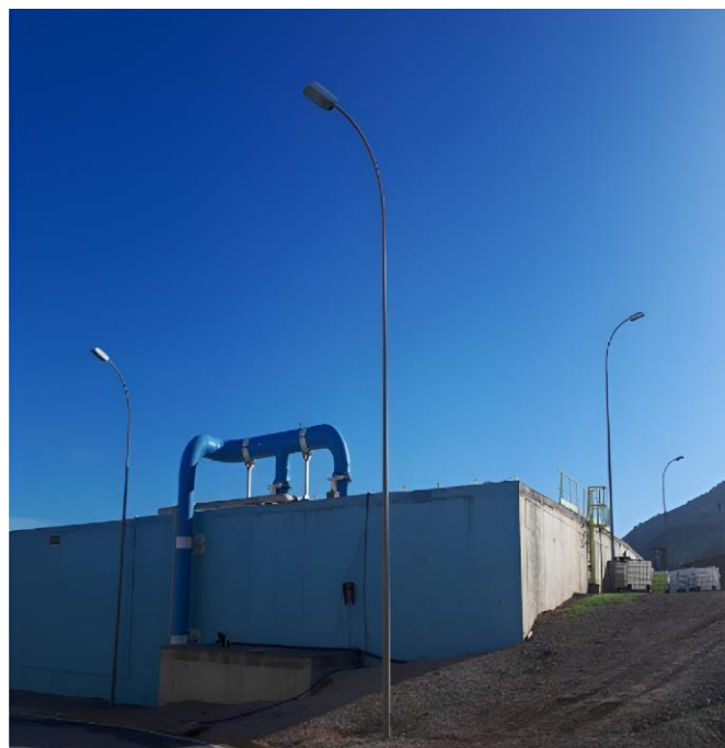
Figure I.17 : photo illustrant le réservoir de stockage de l'eau dessalée produite
