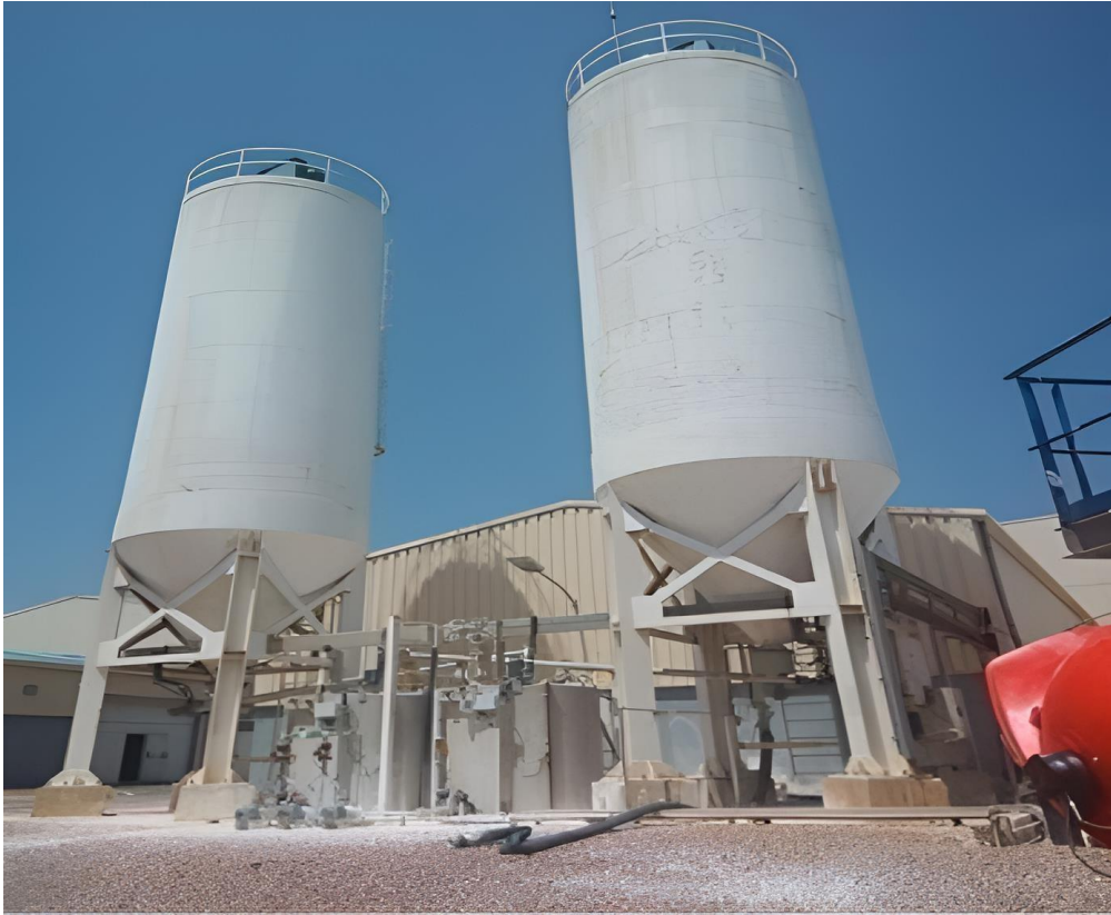
Figure I.12 : photo prise dans la station de dessalement illustrant les silos de stockage de \text{CaCO}_3
