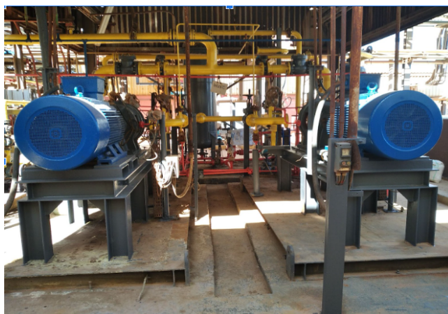
FIGURE 2.1 – L’unité de compression du chlore
