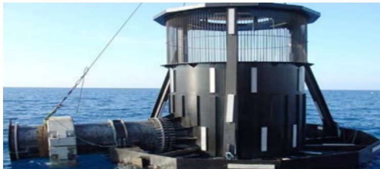
FIG. 3.3: Tour de captage ( Rapport Final de Fouka 1 )
