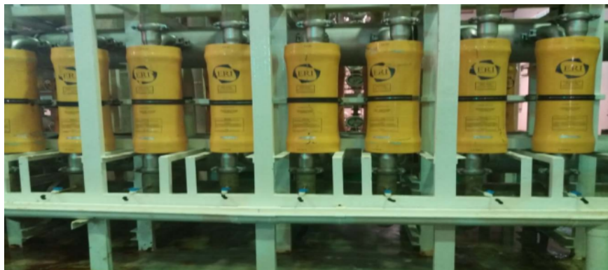
FIG. 3.12: Système de récupération d'énergie ( Rapport Final de Fouka 1 )
