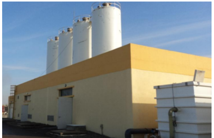
FIG. 3.13: Silos de la chaux ( Rapport Final de Fouka 1 )
