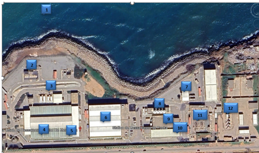
FIG. 3.2: Description générale de la station de Fouka 1
