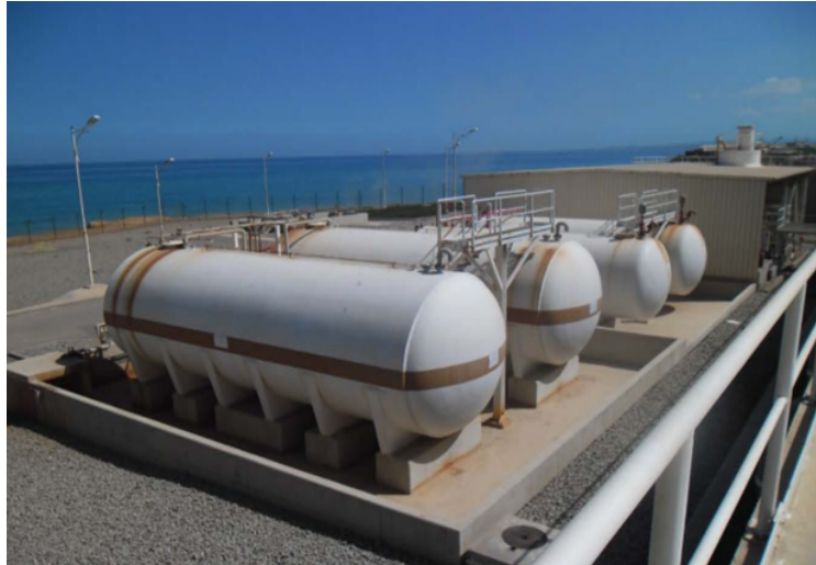
FIG. 3.6: Réservoirs des produits chimiques( Rapport Final de Fouka 1 )
