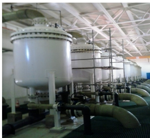
FIG. 3.8: Filtre à cartouche (Rapport Final de Fouka 1)
