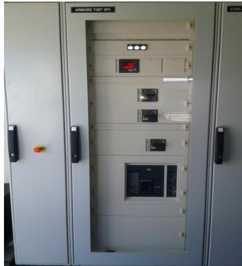
Figure IV-7 Armoire départ arrivé.
