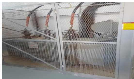
Figure IV-5 Transformateur abaisseur.
