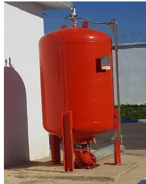
Figure IV-12 Anti-béliet ligne HADJ YAKOUB.
