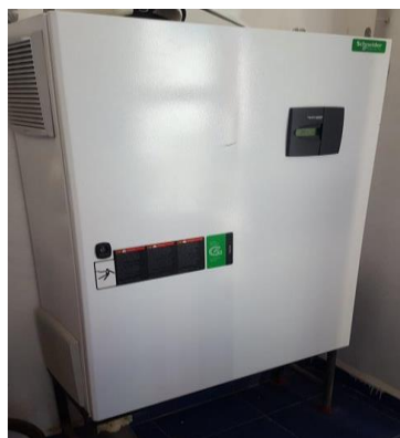
Figure IV-10 Armoire batterie de compensation.
