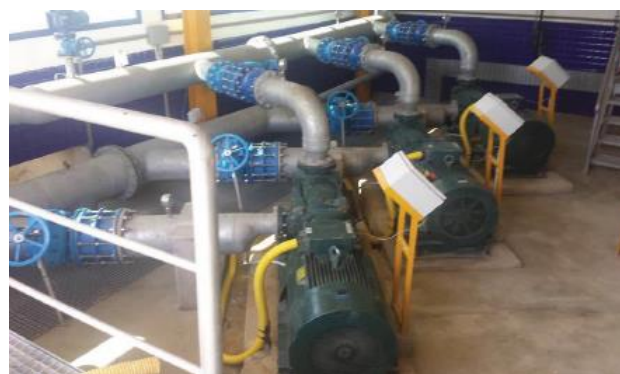
Figure IV-3 GEP de refoulement ligne DEKAKNA.
