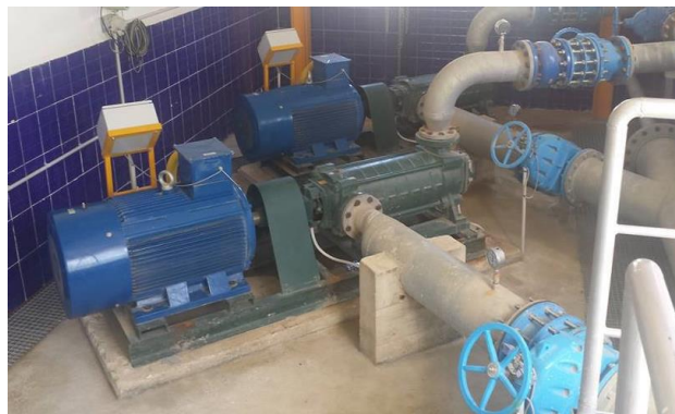
Figure IV-2 GEP de refoulement ligne HADJ YAKOUB.
