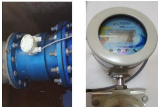
Figure IV-13 débitmètre électromagnétique et son convertisseur.
