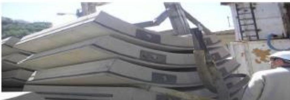
Figure 12 : Voussoirs préfabriqués en béton armé. [19]
