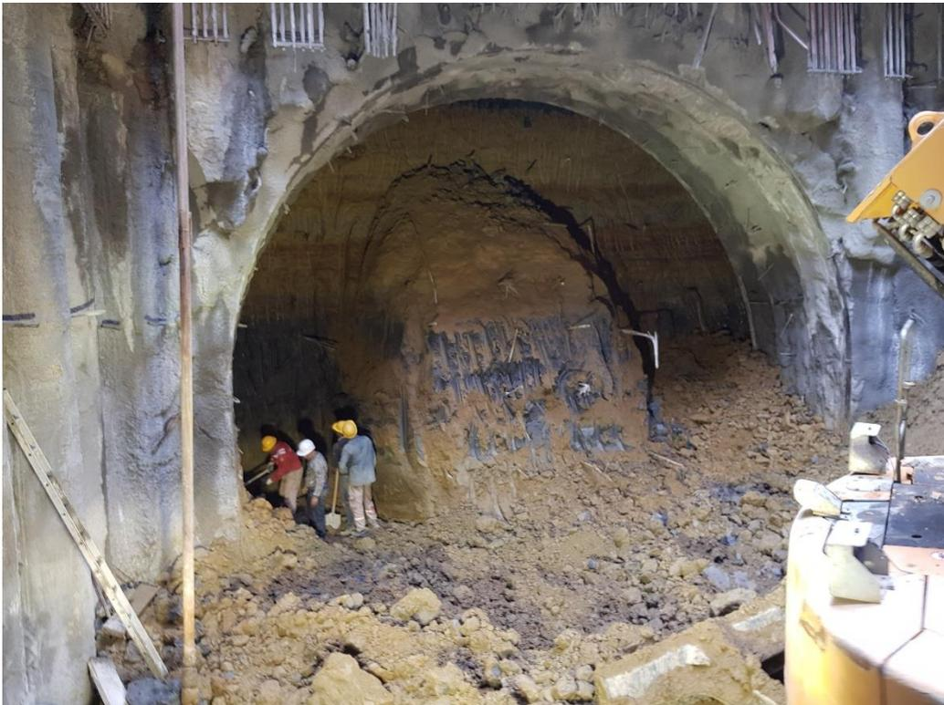
Figure 5 : Creusement de rameau de connexion # PV5 en pleine section. [13]
