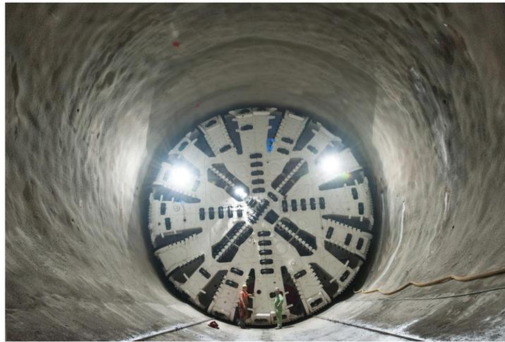
Figure 4 : Machine pleine section (TBM). [31]
