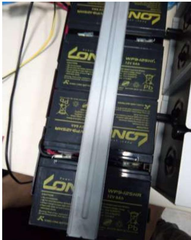
Figure 4.38 : Les 4 batteries 12V/9Ah
