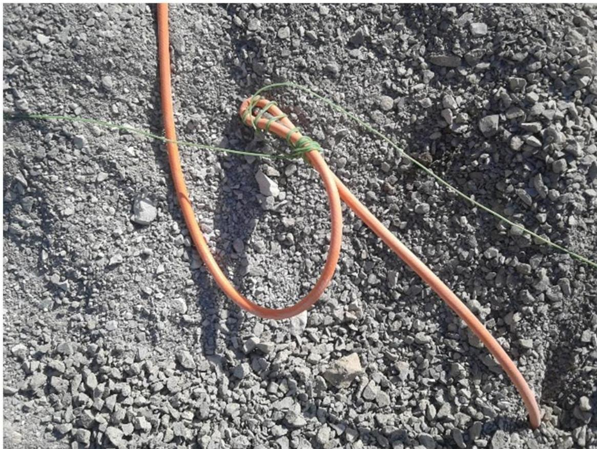
**Figure III.9 :** L'amorçage avec un détonateur électrique
