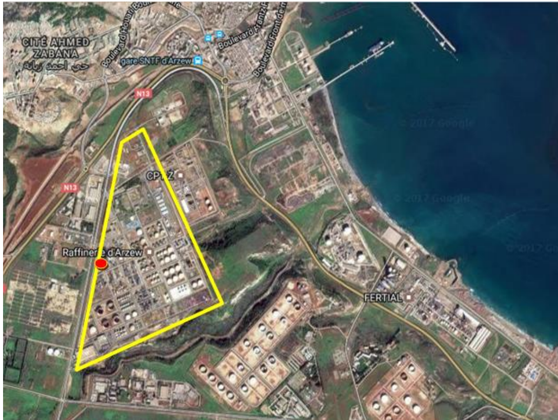
Fig. 1.2 : Vue satellite de la raffinerie d'Arzew [3]
