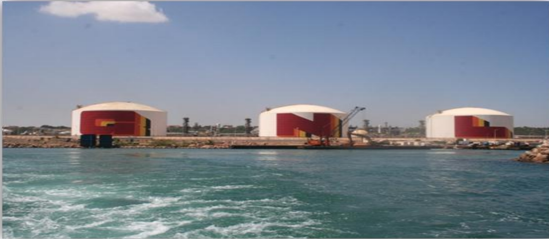
Figure I.8 : Photo montrant les réservoirs de stockage.
