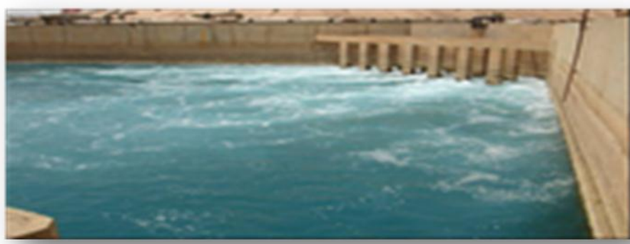
Figure I.3 : Photo montrant le bassin récepteur d'eau de mer.
