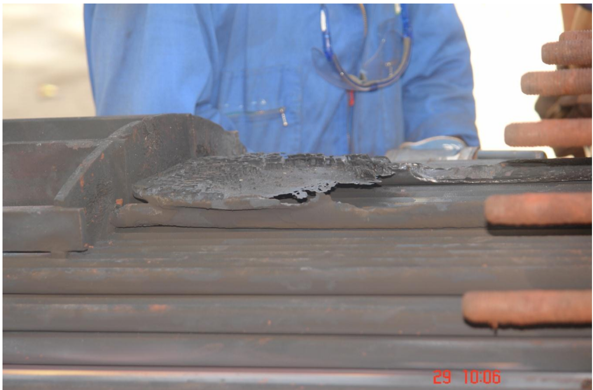
Figure V.5: Photo montrant la dégradation de la plaque déflectrice2.
