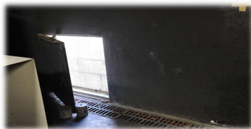
Figure 29 : Trappe entrée d'air.
