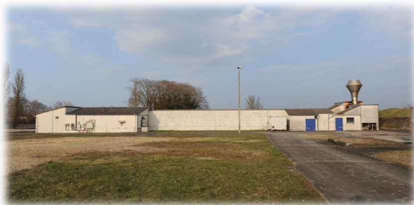
Figure 27 : Vue extérieure de l'installation
