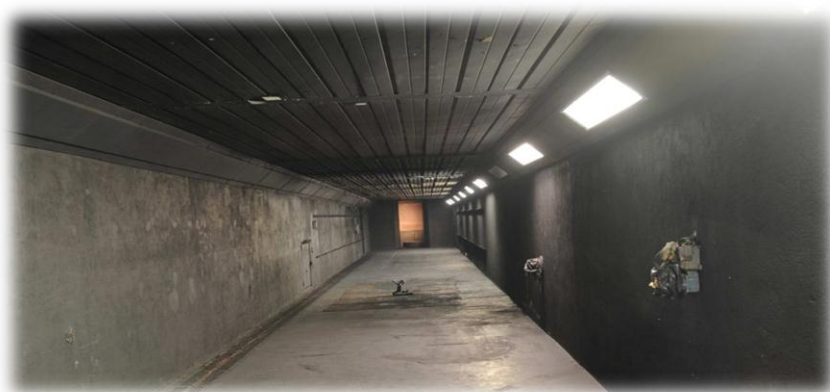
Figure 28 : Entrée du tunnel
