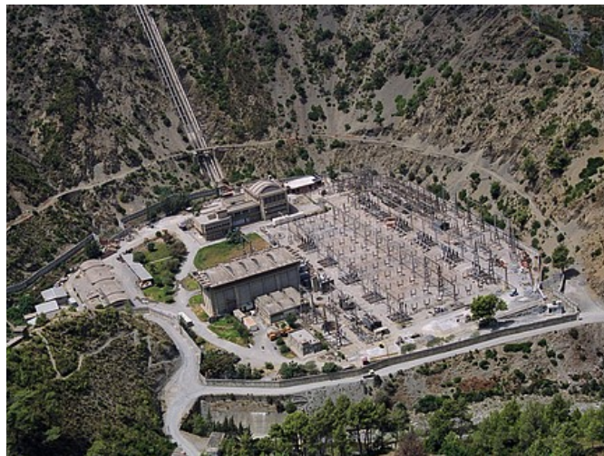
Figure IV-8 Vue aérienne de la centrale de DARGUINA
