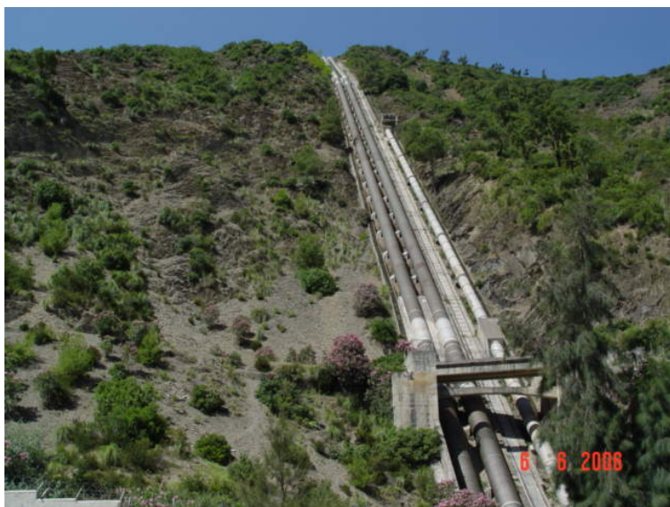
Figure IV-9 La conduite forcée de la centrale de DARGUINA
