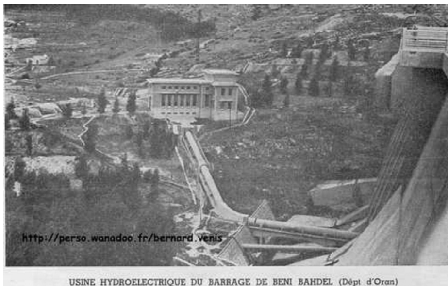
Figure III-1 Usine hydroélectrique du barrage de BENI BAHDEL (Wilaya Oran)
