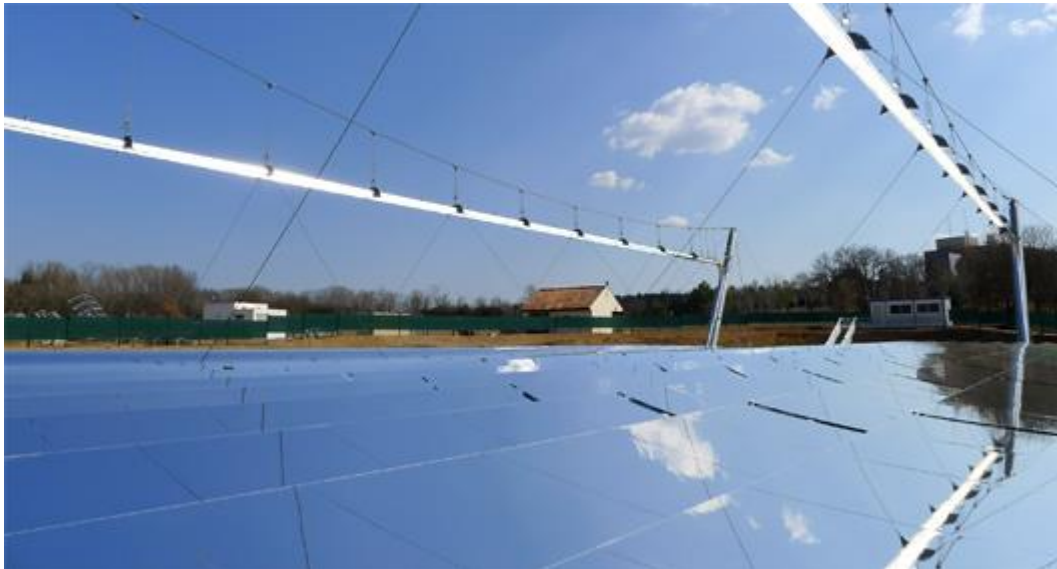
Figure II.4 Centrale solaire thermodynamique à miroirs de Fresnel [13]
