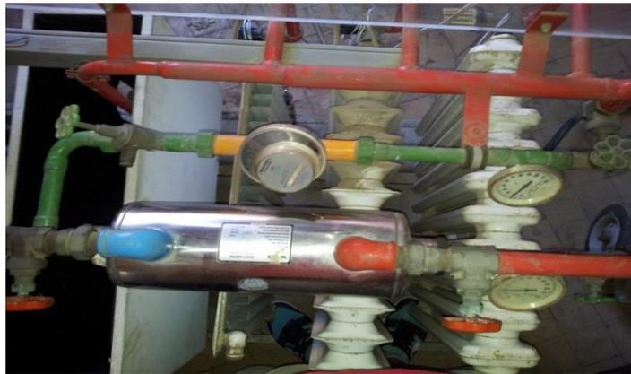
Figure 2.14 : Régulateur à contre-courant
