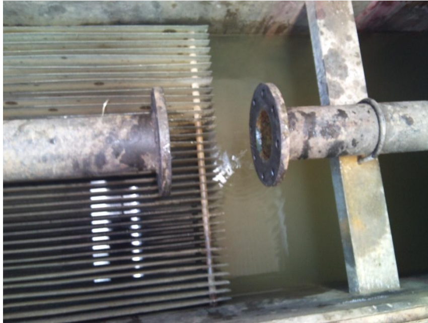
Figure III.6 : Position de l'élément déprimogène dans la canalisation après son démontage.
