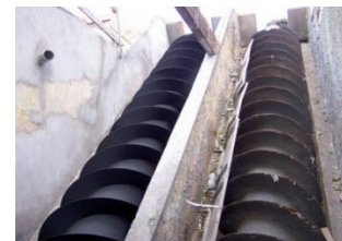
Fig.I.3. Vis avant et après restauration
