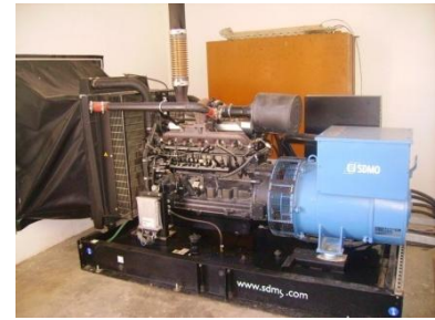
Fig.I.6. Groupe électrogène
