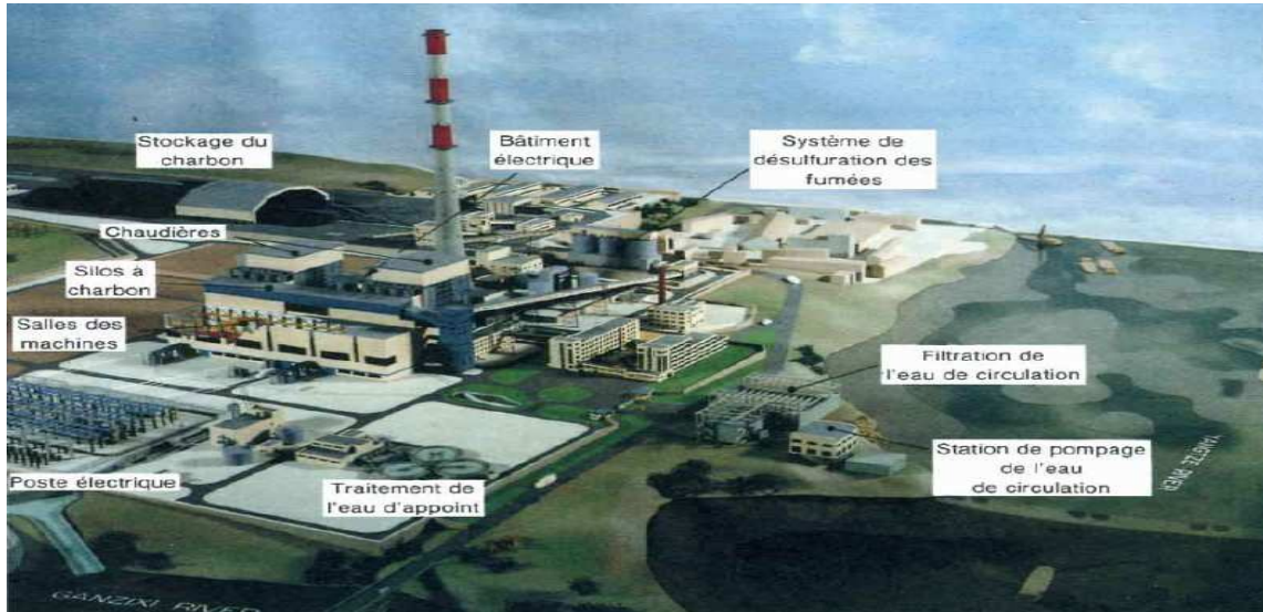
Fig. I.1 : Maquette de la centrale thermique classique à vapeur de Luohuang en Chine 2 unités de 360 MW [2].
