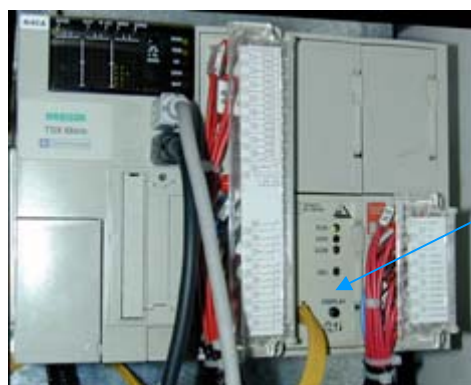
Figure IV.23: Position du coupleur AS-i dans le rack
