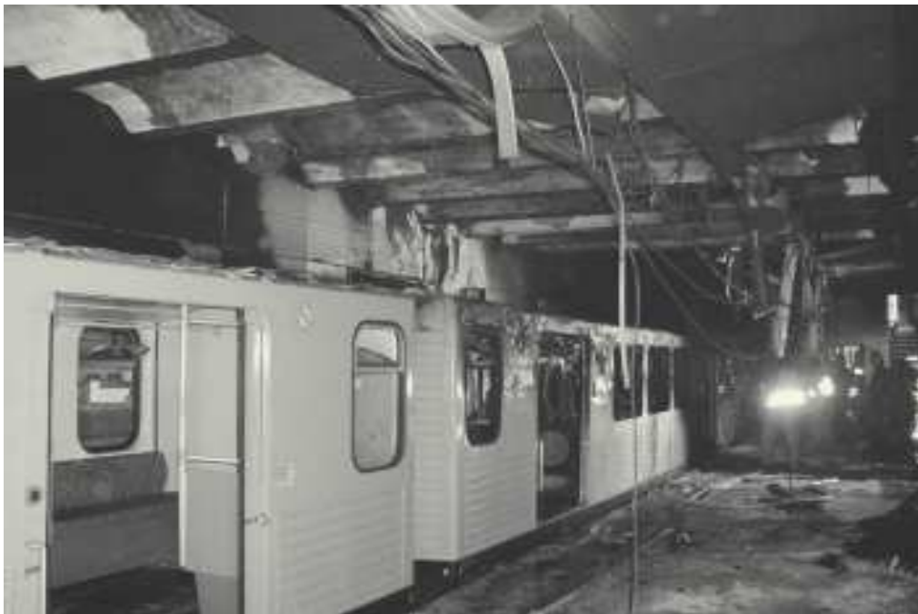
Fig.1.1 : Incendie dans la station Deutsche Oper à Berlin (2000) [4]
