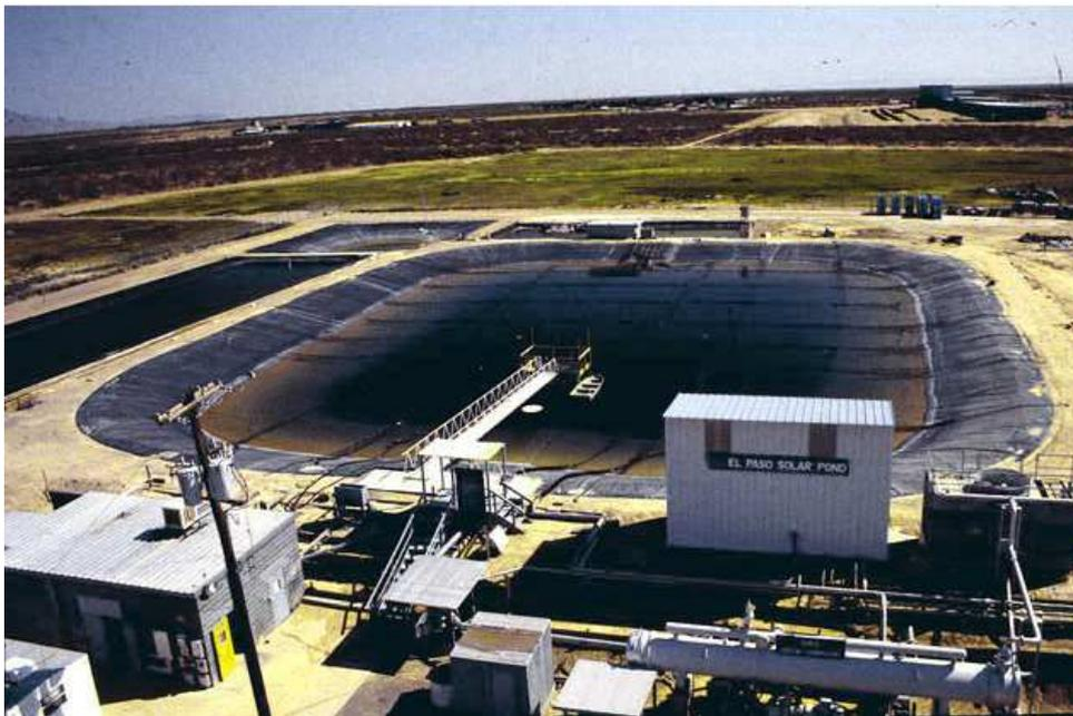
Figure A.7 : Etang solaire de l'université de Texas à El Paso
