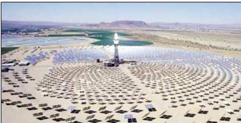
Figure A.1 : Vue de la centrale SOLAR two avec 1926 héliostats autour de la tour
