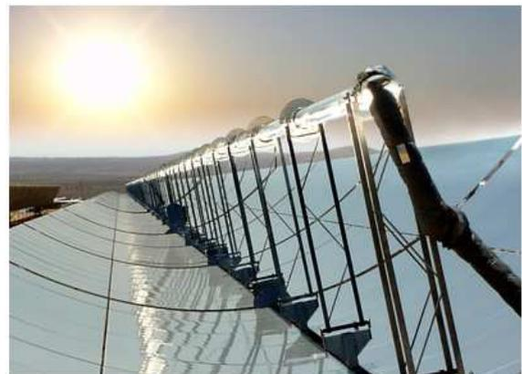
Figure A.3: Capteur cylindro-parabolique de la centrale Californie
