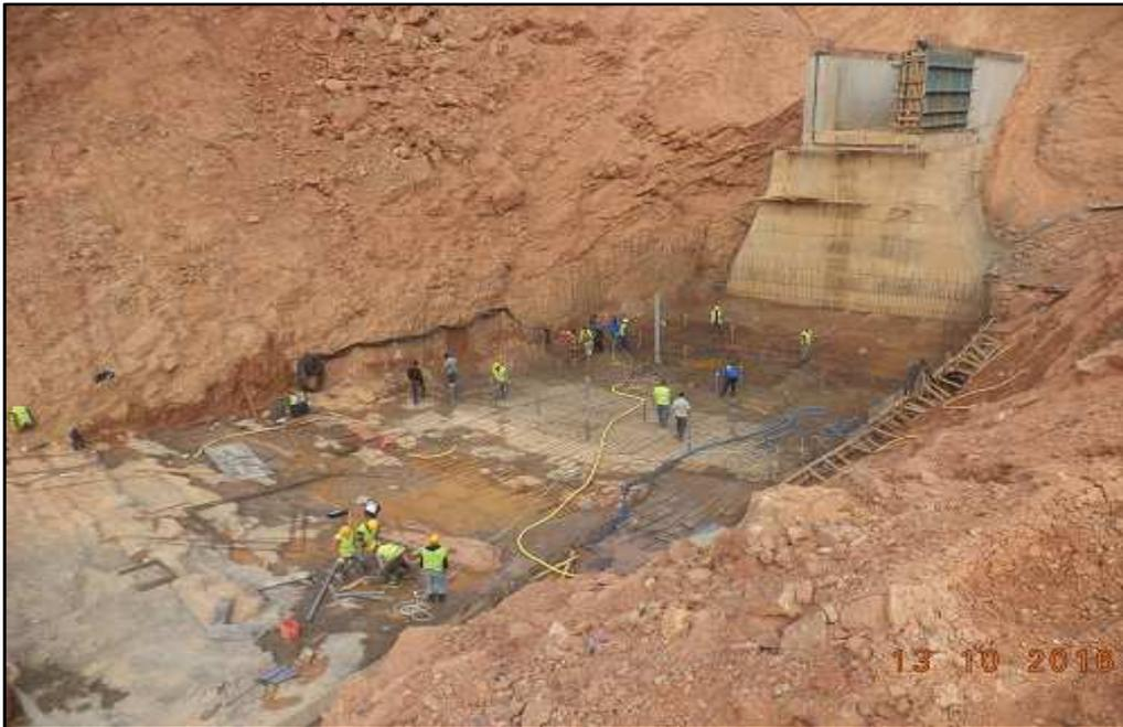
Figure 5.6 : Le déroulement des étapes avant le coulage du coursier
