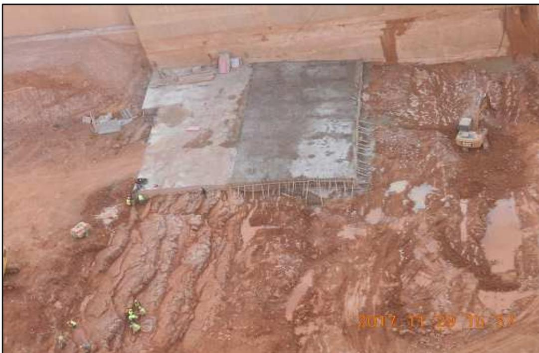
Figure 5.11 : Mode de coulage de la première couche en contact avec le substratum
