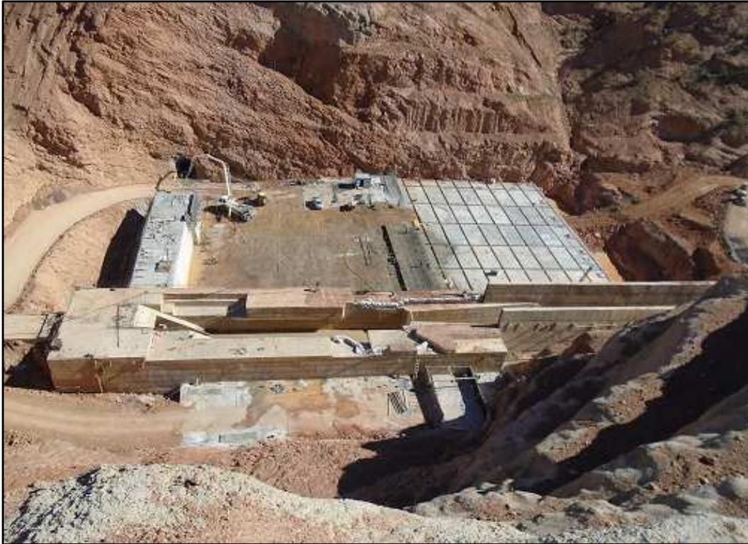
Figure 5.12 : Le déclenchement de coulage d'autres compartiments
