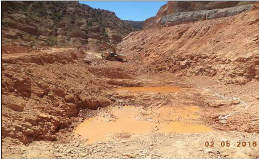
Figure 5.1 : Excavation rive droite jusqu'à la dérivation provisoire
