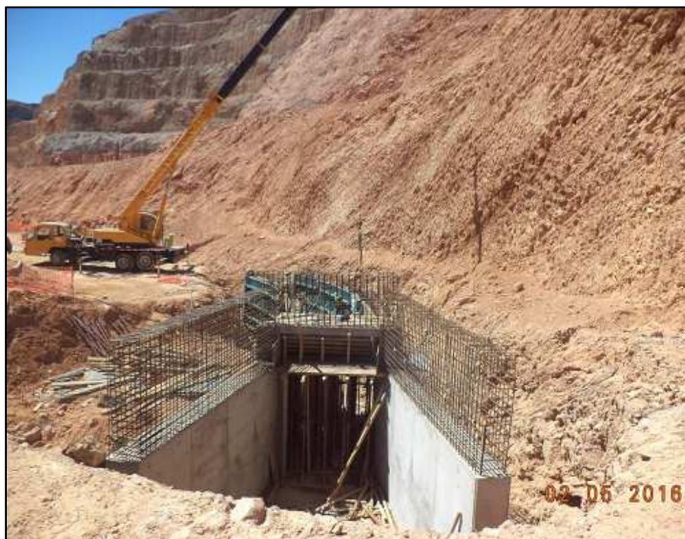
Figure 5.3 : La deuxième phase de coulage de la paroi supérieure
