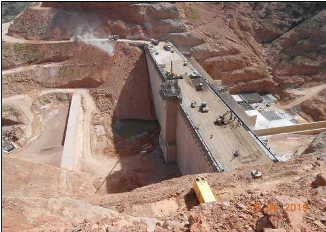
Figure 5.14 : Avancement de coulage de la digue et accessoires
