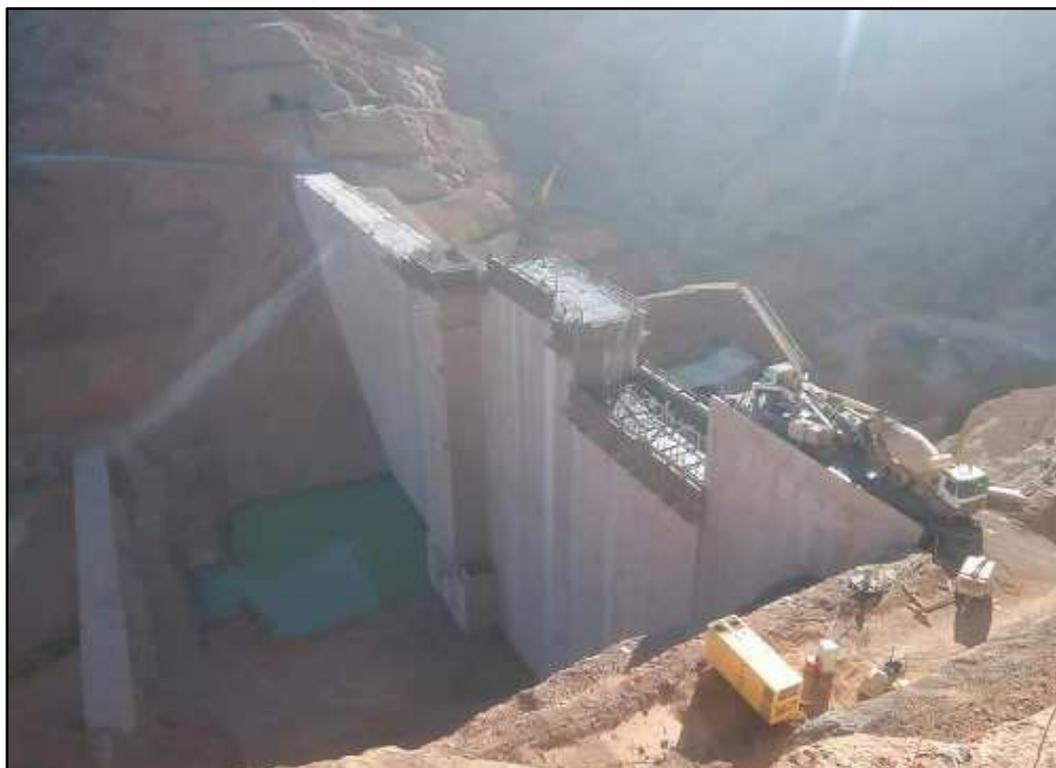
Figure 5.25 : Le coulage de la crête dépassant le niveau de l'évacuateur de crues.
