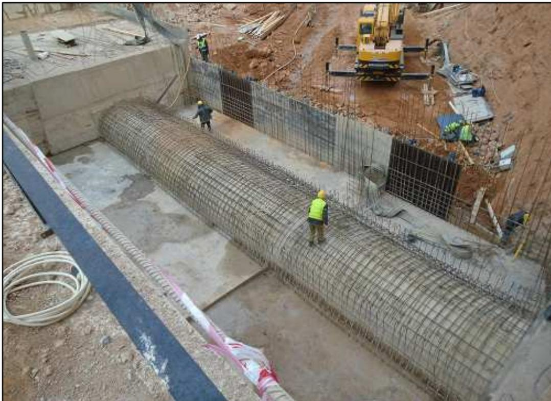
Figure 5.13 : Exécution du canal de prise
