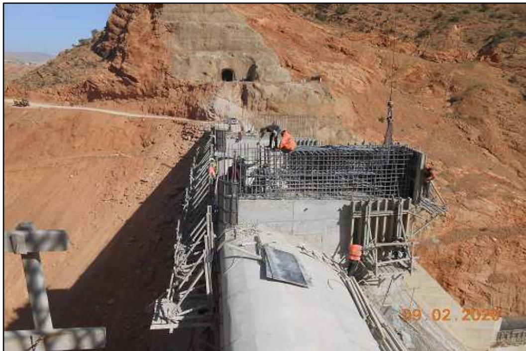
Figure 5.22 : Les travaux sur la tour de prise et les parois de l'évacuateur des crues
