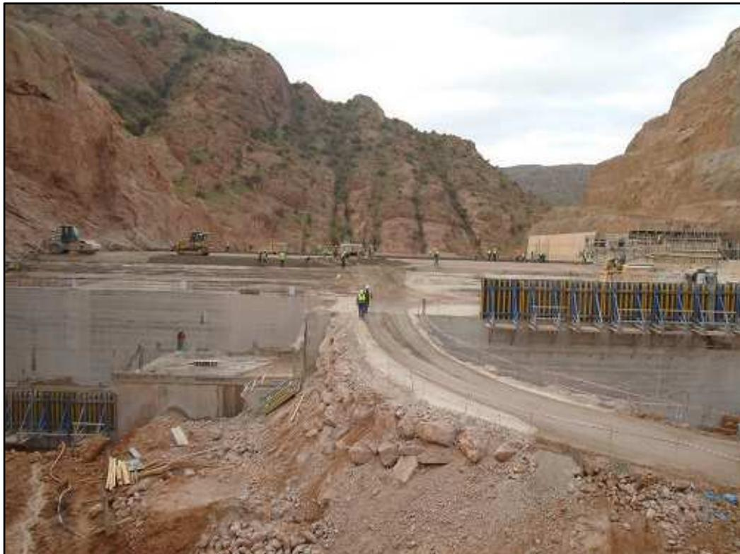
Figure 5.17 : Les différentes étapes de coulage par étage
