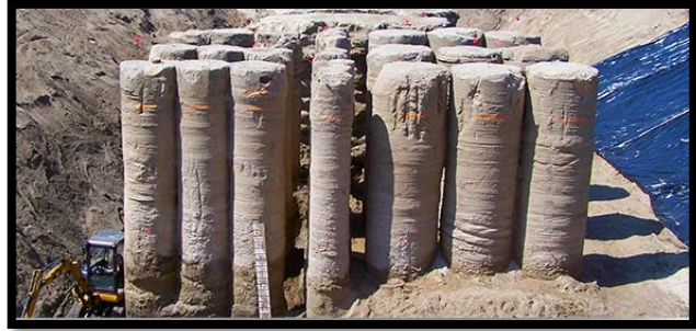
Figure 2-14 : Parois en Soilmix
