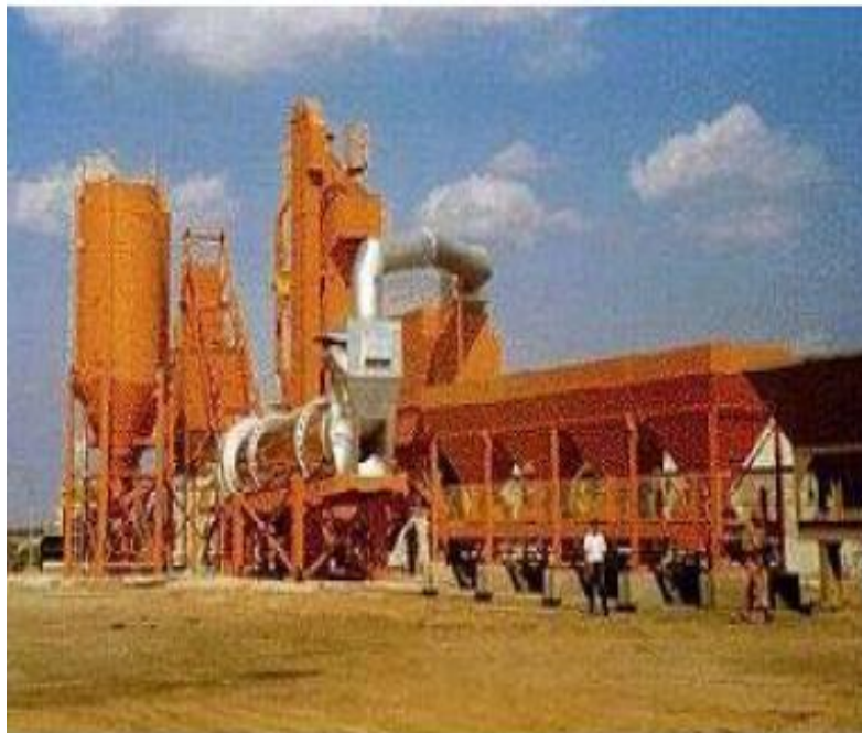
Figure I.9. Centrale d'enrobage discontinue [7].
