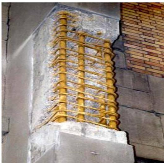
*Figure I.6 : Réfection du béton et protection des armatures.*
