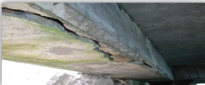
*Figure I.3: Poutre de tablier de pont dégradée [3].*
