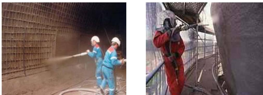
*Figure 1.7 : Renforcement au moyen de béton projeté. [www.mtps.fr](http://www.mtps.fr)*
