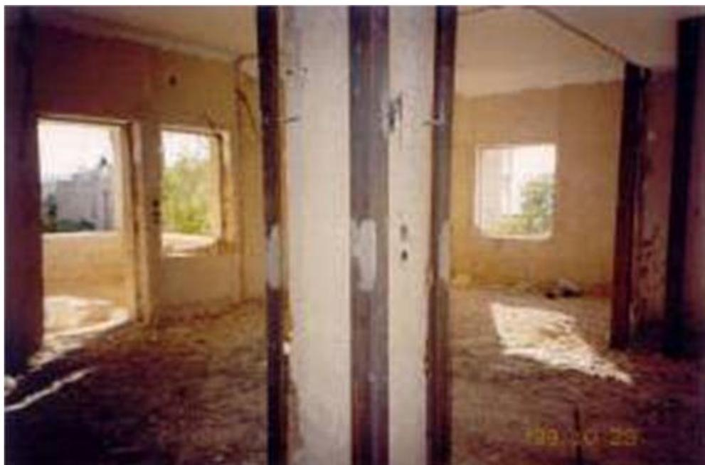
*Figure 1.11 : Renforcement de poteaux au moyen de profilés métallique [2].*
