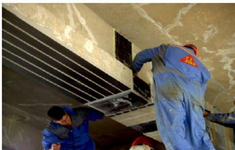
*Figure 1.9 : Renforcement par collage d'un tissu de fibres de carbone TFC. [www.mts.fr](http://www.mts.fr)*
