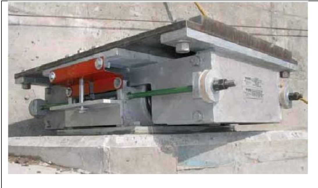
Figure I.15 : Isolateur sismique utilisé dans le pont de la rivière bostonnais, QC [11]
