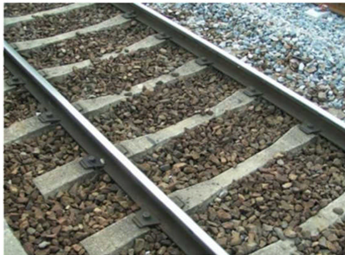
Figure N° II-13 rail travers et ballaste
