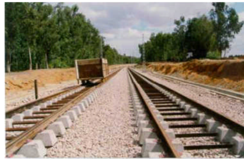
Figure N° II-15 : Traverse en béton
