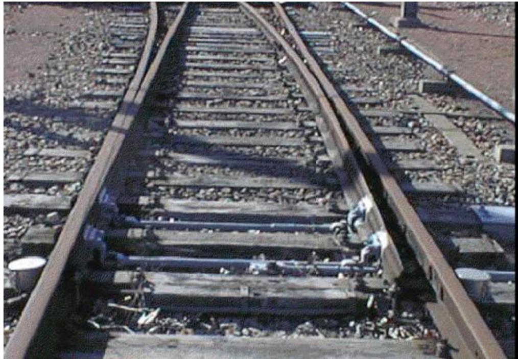
*Fig. II.1 Aiguillage manœuvré par transmission rigide*
