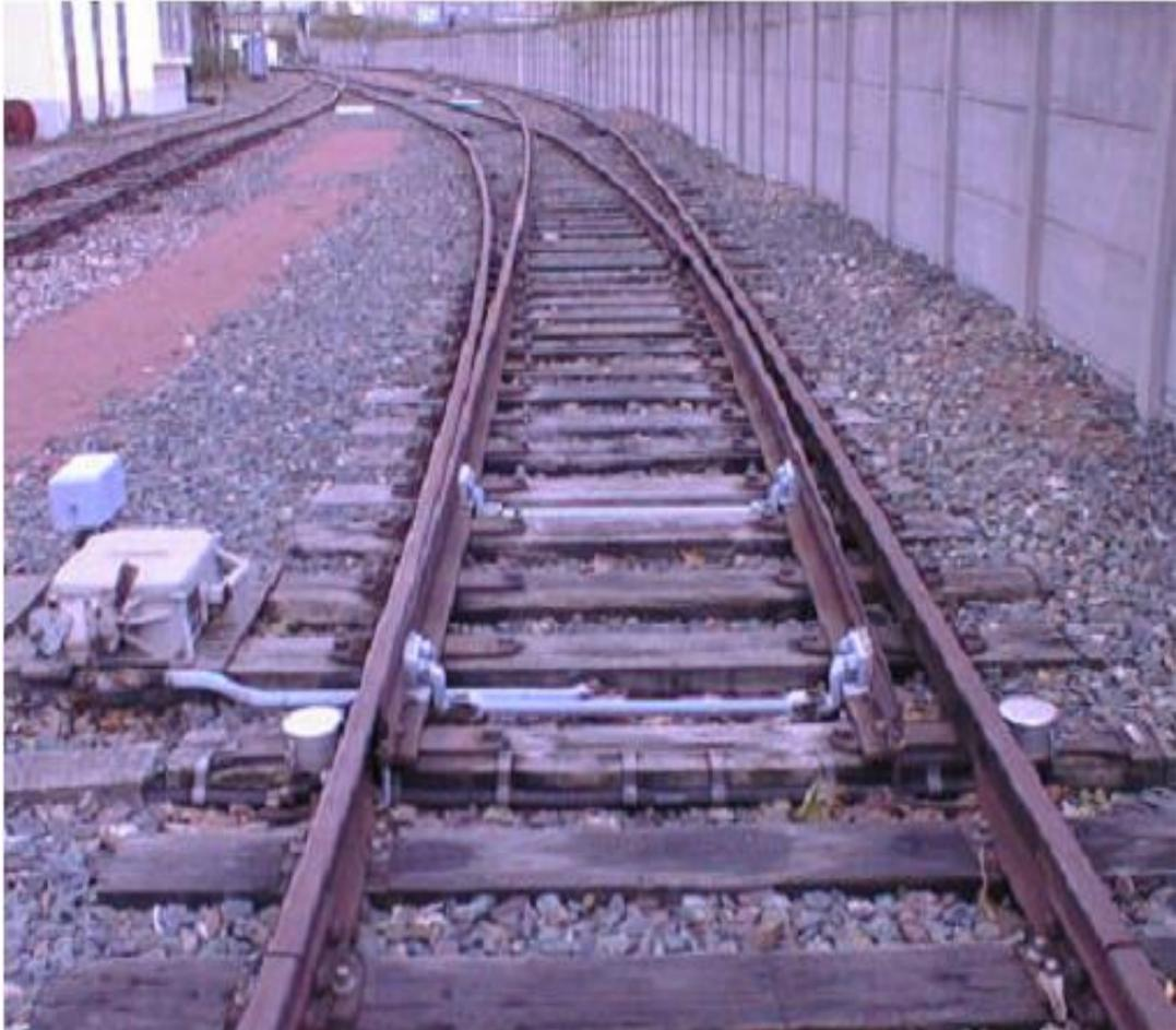
*Fig. II.3 Aiguillage déviation à gauche cintré à gauche*
