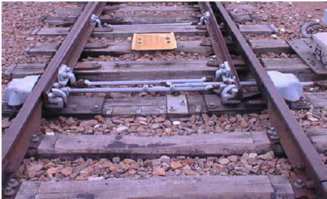
*Fig. II.2 Aiguillage manœuvré par mécanisme électrique*
