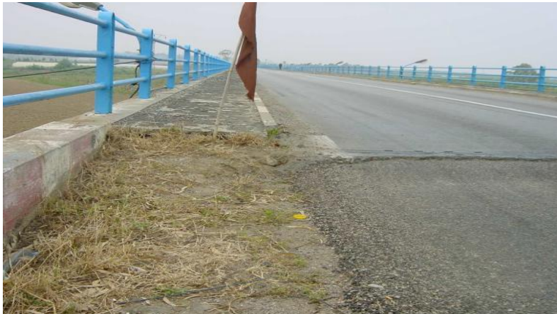
Figure I.12. Tassements derrière la culée d'un pont à Boumerdès, "Algérie 2003" [13]
