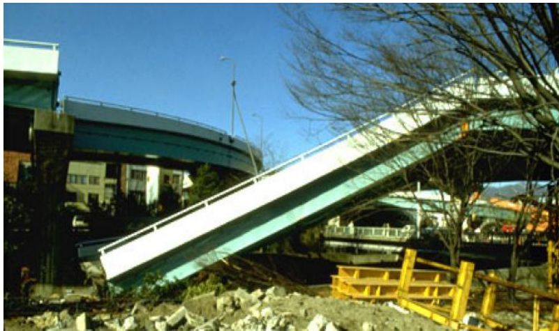
Figure I.4. Chute du tablier d'un pont lors du tremblement de terre de Kobe en 1995 [5]
