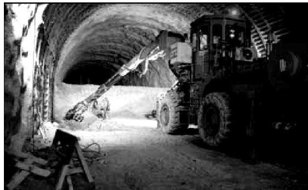
Figure II.2 : Creusement en demi-section [8]
