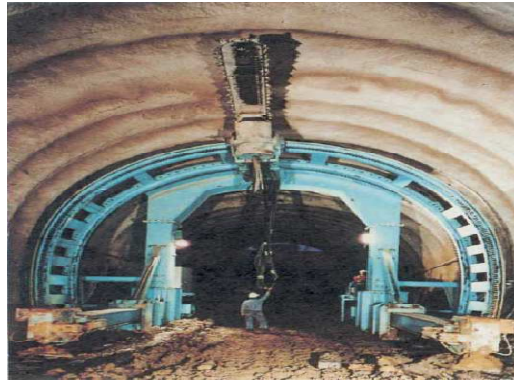
Figure II.5 : Machine de pré-découpage pleine section [8]
