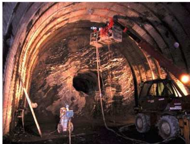
Figure I.1 : Exemple d'une galerie de reconnaissance [11]
