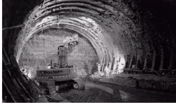
Figure II.1 : Creusement en pleine section [8]
