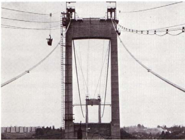
Fig. III.1. Lancement des câbles porteurs
