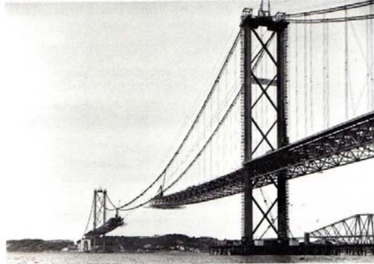
Fig. III.3. Construction de la poutre de rigidité à partir des appuis
