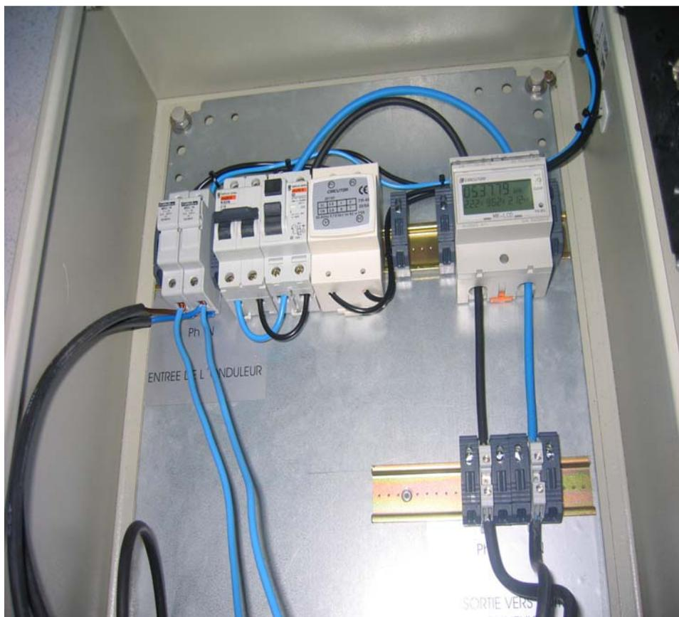
Figure 3.19 : Câblage, fusibles, disjoncteurs et compteur d'énergie de l'armoire AC
