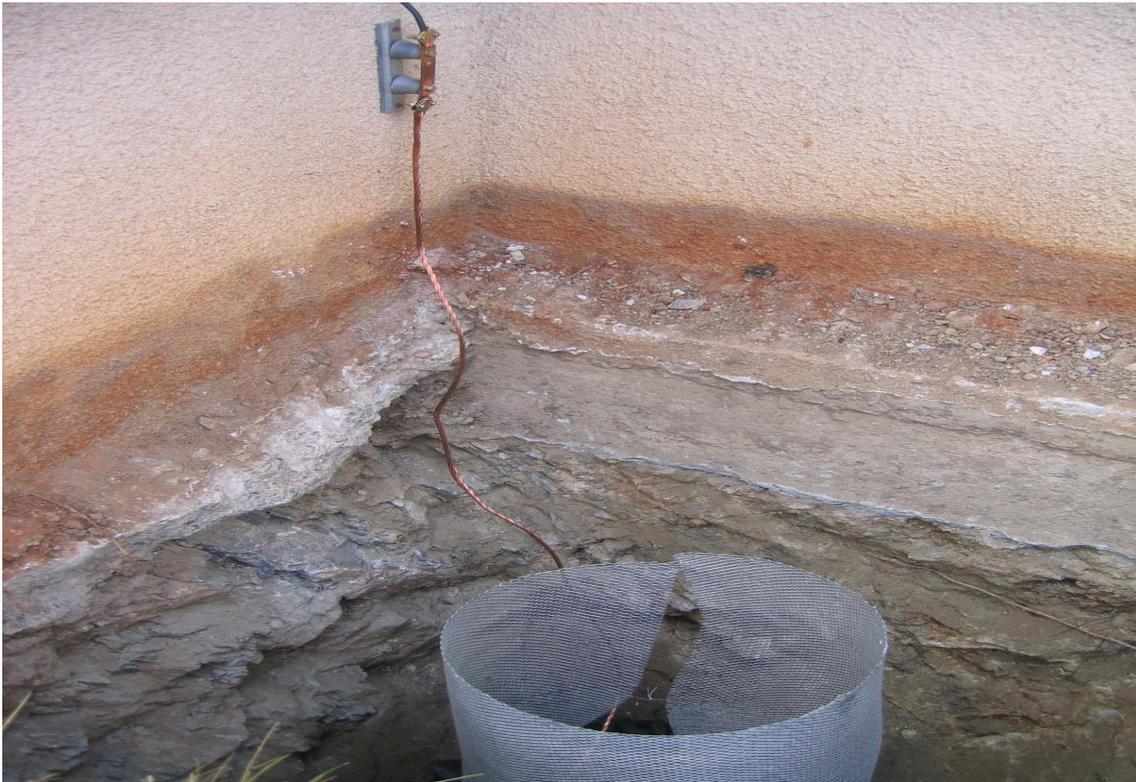
Figure 3.9 : Mise à la terre du générateur
