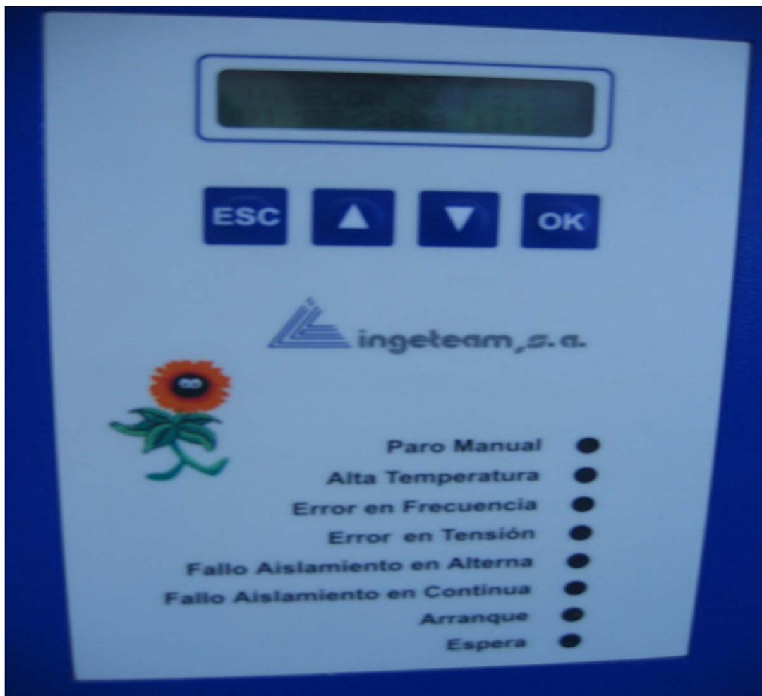
Figure 3.17 : Ecran, clavier de monotorisation et différentes leds indiquant les erreurs.
