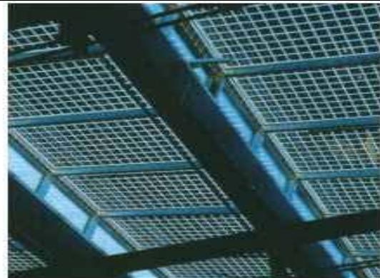
Figure 12 : Sheds PV en verre isolant par SGG Prosol au siège de HUK Coburg.
