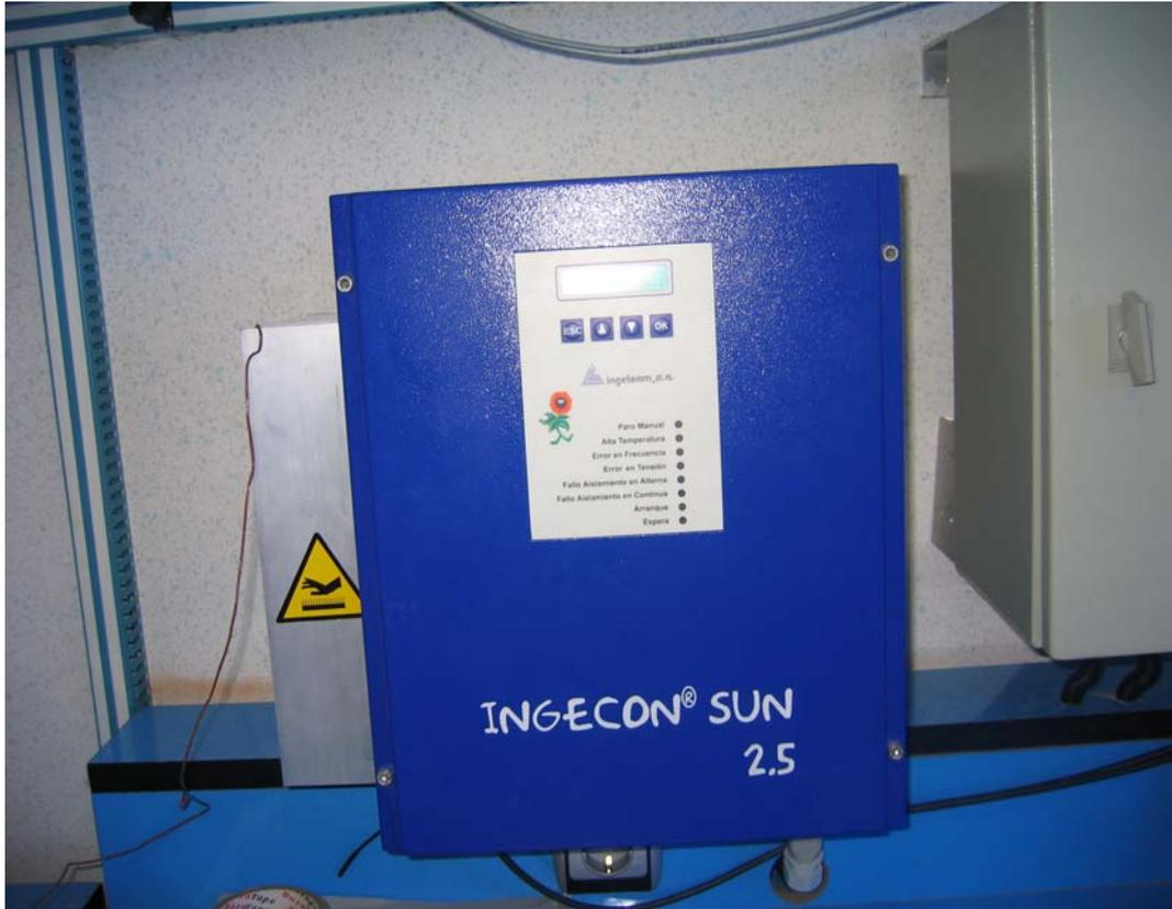
Figure 3.14: Face avant de l'onduleur
