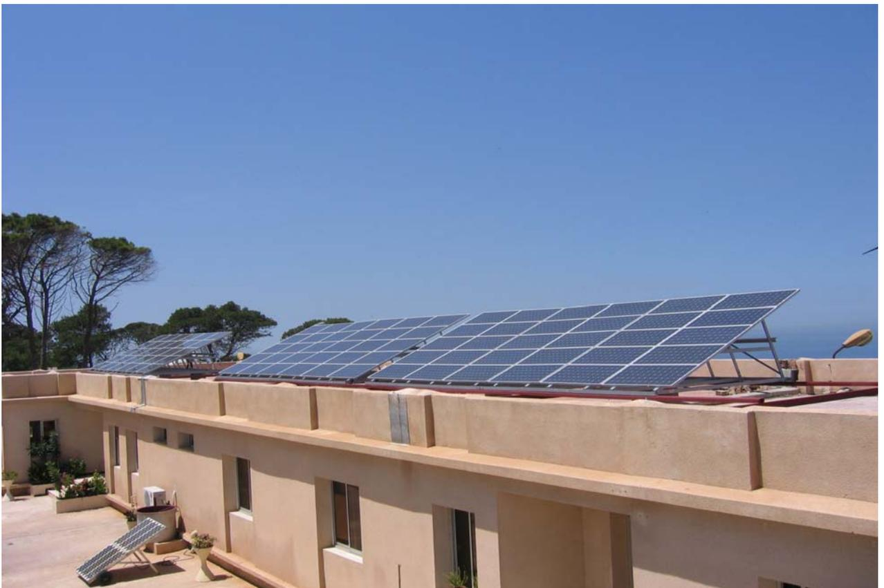
Figure 3.3 : Photo des trois champs de modules constituant le générateur PV.
