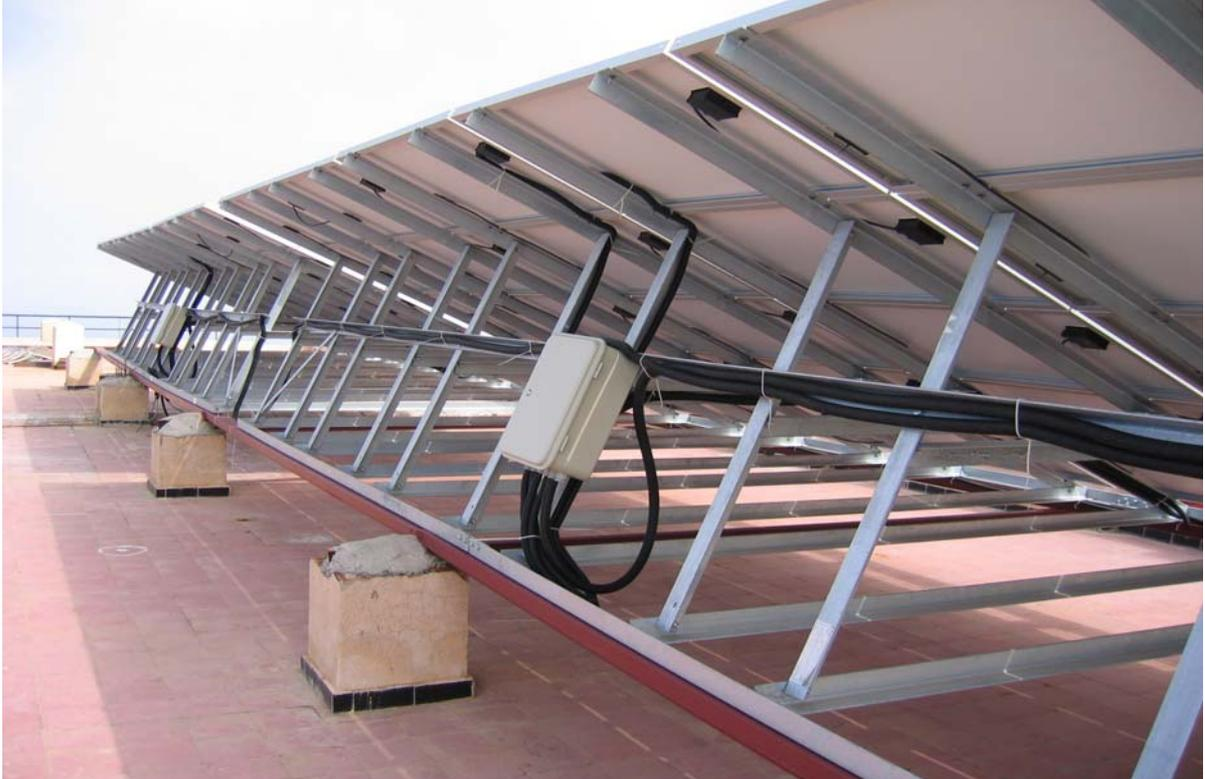
Figure 3.5 : Gains de protections des câbles
