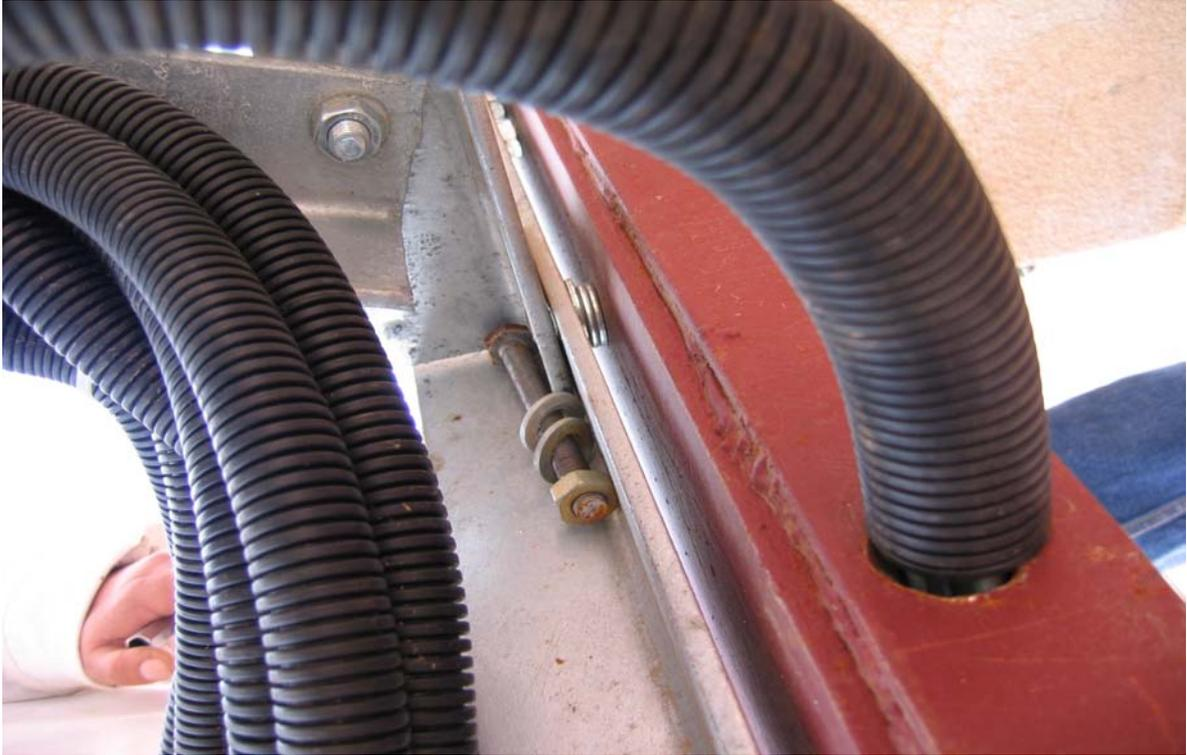
Figure 3.6 : Passage des câbles dans les UPN
