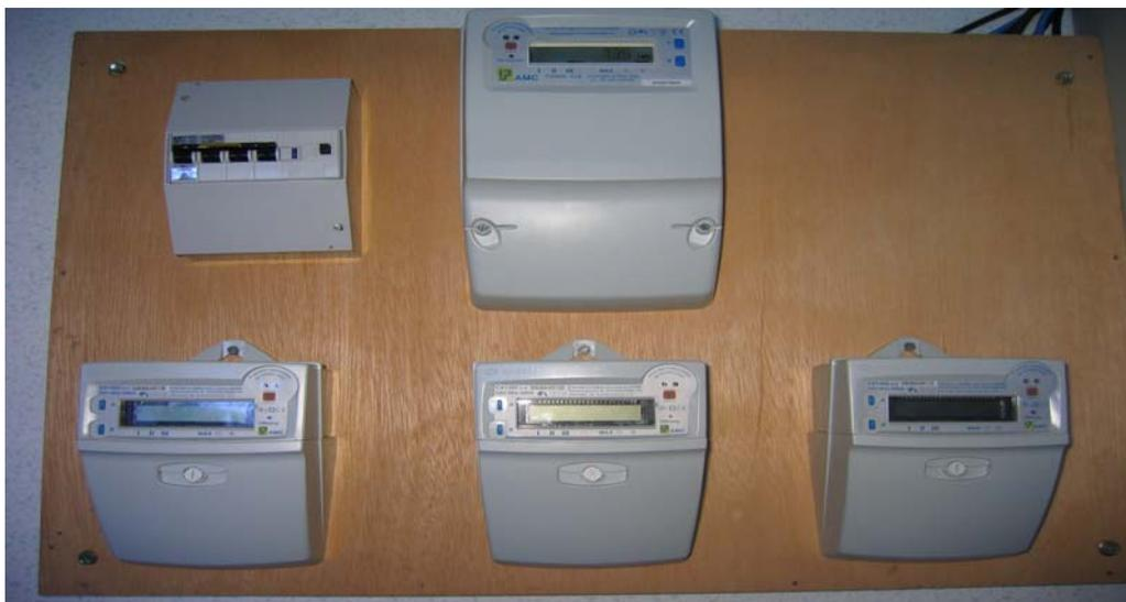
Figure 3.26 : Disjoncteur de connexion au réseau et les compteurs électroniques AMC
