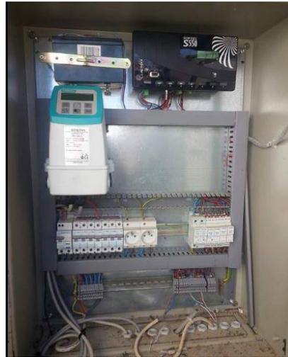
*Figure 15- Armoire électrique du réservoir.*
