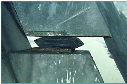
Figure III. 3: Distorsion d'un appareil d'appui [8].
