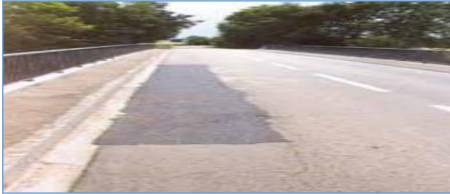
Figure III. 1: Entretien de la chape d'étanchéité d'un tablier [8].
