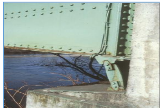
Figure I. 16: Appareils d'appui mobiles balancier métallique [8].
