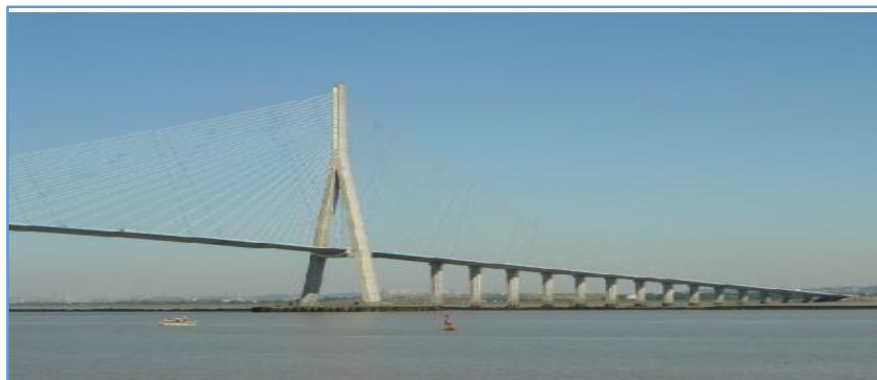
Figure I. 7: Pont de Normandie (pont à haubans) [10].
