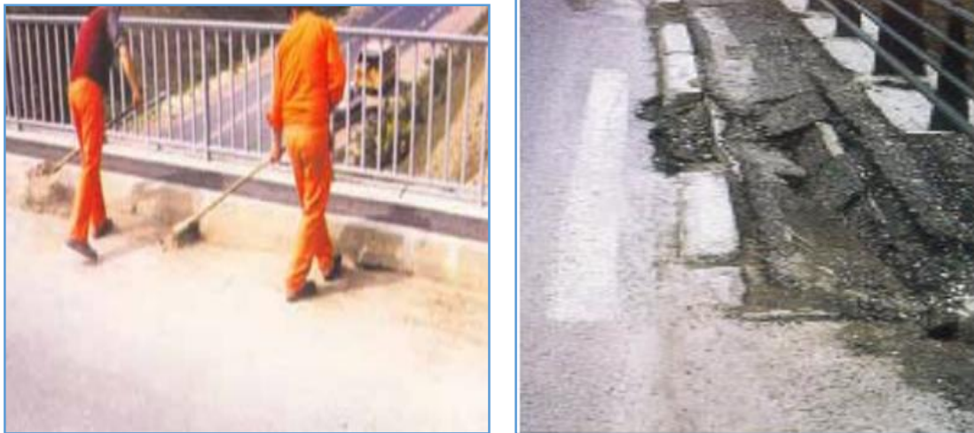
Figure III. 2: Entretien des trottoirs et bordures [2].
