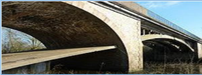
Figure I. 5: Pont de la Planche à Liré (Maine- et – Loire) [10].
