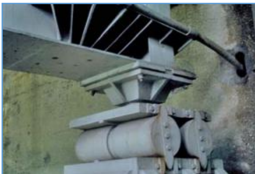
Figure I. 15: appareil d'appui métallique combinant un rouleau et une rotule [8].
