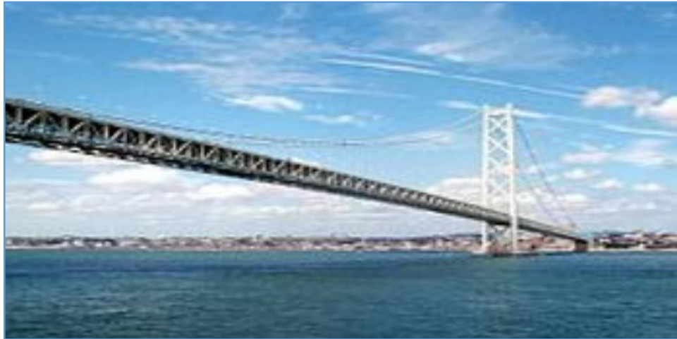
Figure I. 8: Le pont du détroit d'Akashi a la plus grande portée[10].
