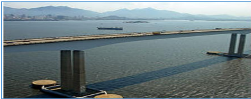
Figure I. 6: Pont Rio - Rio de Janeiro- Pont à outres métalliques [10].
