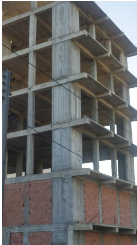
Figure III.1 Image réelle du bâtiment.
