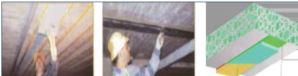
Figure IV.2. Réparation par l'utilisation des tôles collées
