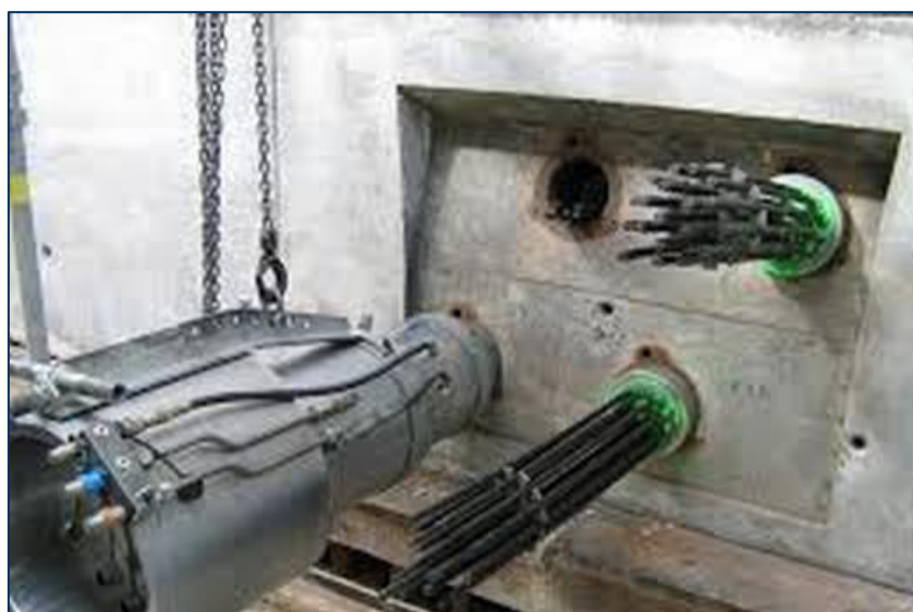
Figure IV.4. Remplacement des câbles de précontrainte
