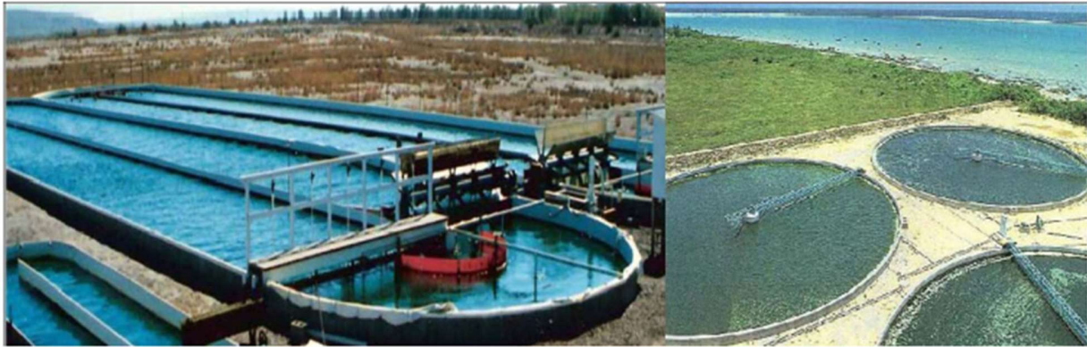
Figure 2.10 Bassins de culture des microalgues. A gauche : bassin en boucle fermée, infrastructure de Roswell, Nouveau Mexique (USA) [45]. A droite : bassins circulaires d'environ 500 m 2 , production de chlorelle (Chlorella Industries, Japon) [46].
