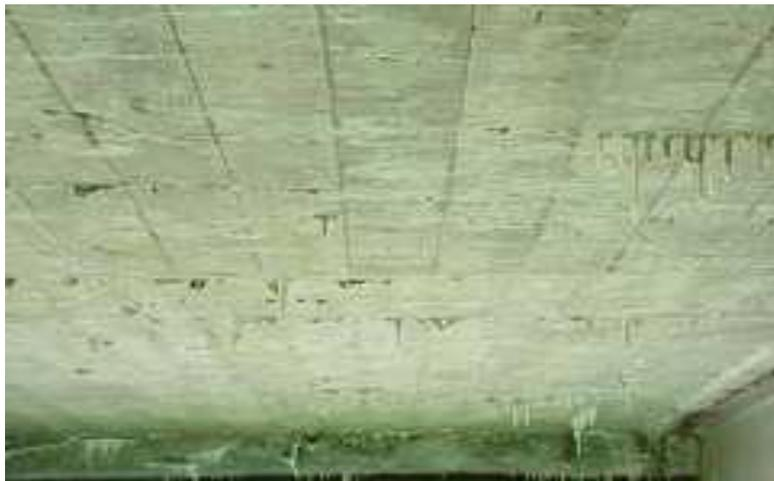
*Figure I.12. Efflorescence de dalle du pont*
