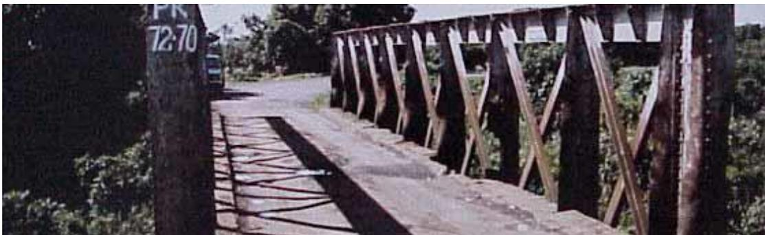
**Fig III.6. Pont Pigeaud – assemblages par boulons ordinaires**
