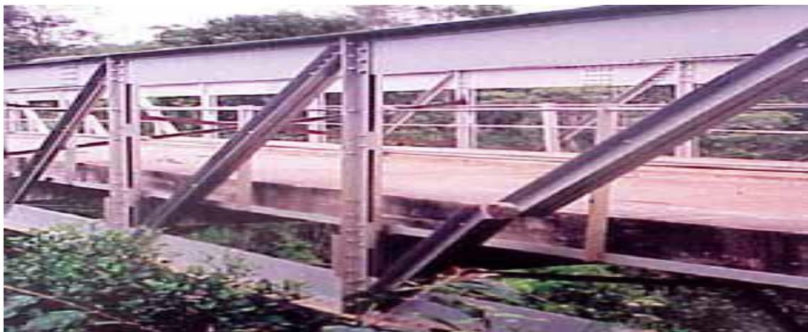
**FIG I. 5.** Rupture d'une diagonale tendue sur un point de soudure
