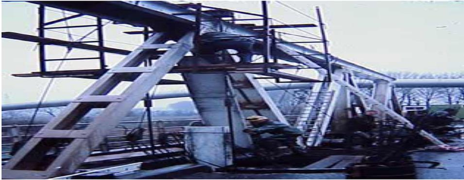
**Fig III.3. Remplacement d'un montant d'une poutre treillis**
