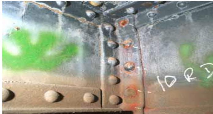
**Fig III.5. Remplacement le rivet défectueux**
