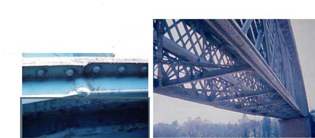
Fig III.4. Ajout de matière sous la membrure inférieure entre lignes de rivets (Pont de Douarnenez) [7]
