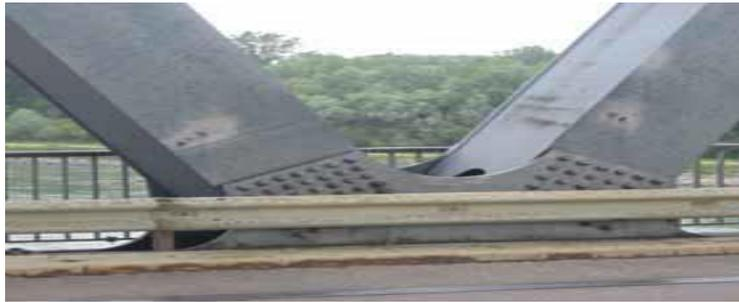
**Fig III.7 .Pont Warren sur le Rhin - Construction soudée –assemblages boulons
