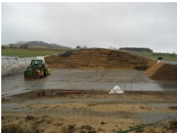
Figure 15 : Stockage des digestats sur une dalle en béton [30]
