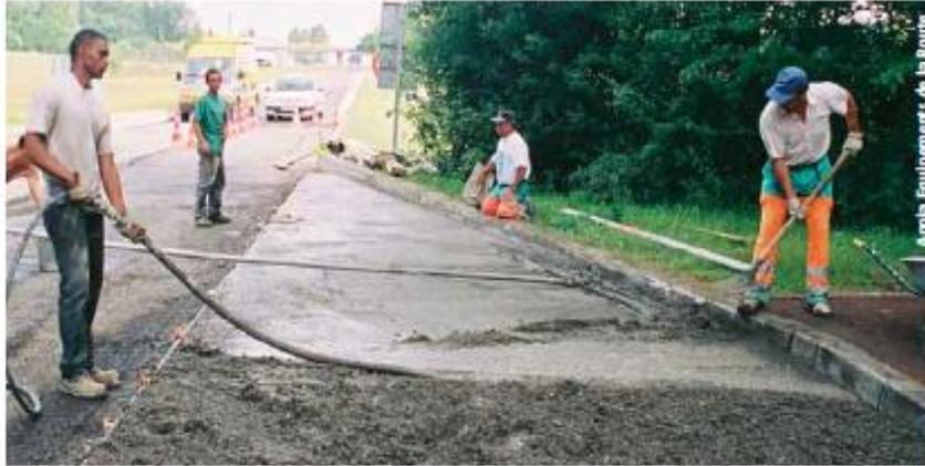
Fig. 1.4 Mise en œuvre du béton de fraisâts sur l'aire des Châtaigniers (Revue RGRA, 2003).
