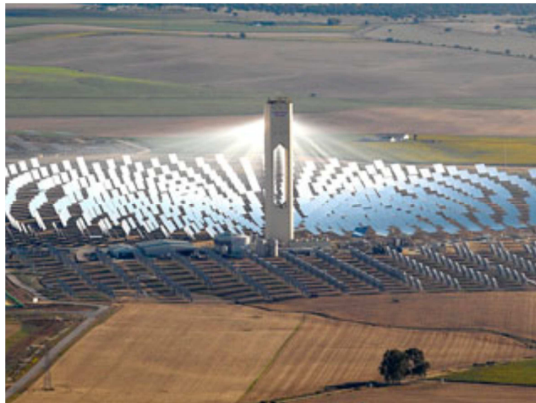
Fig.1.11. Les centrales à tour.
