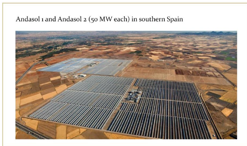
Fig. (27) : Centrales cylindro-paraboliques dans le sud de l'Espagne (Andasol 1 et 2, dans l'arrière sur le côté droit où le terrain de construction est préparé pour Andasol 3, source: Solar Millenium).
