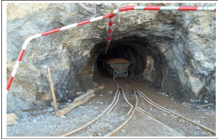
Figure IV.7 : photo numérique de la galerie niveau 1330 m du quartier Lakhdar
