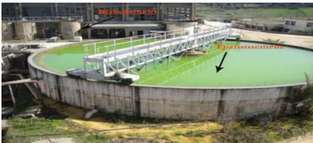
Figure 3-4 : les bassins de décantation
