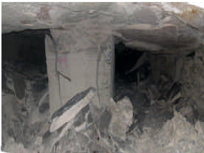
**Figure II.2.** Dégradation d'un pilier dans une exploitation par chambres et piliers.
