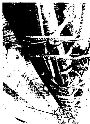
Fig. IV.11- Rupture des câbles précontraints de la poutre de rive à la suite d'un choc de véhicule (Pont oued smar)
