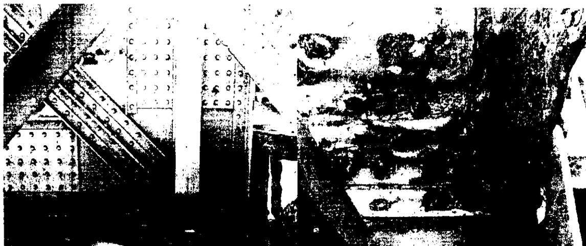
Fig. IV.12- Corrosion des rivets dans un pont métallique
