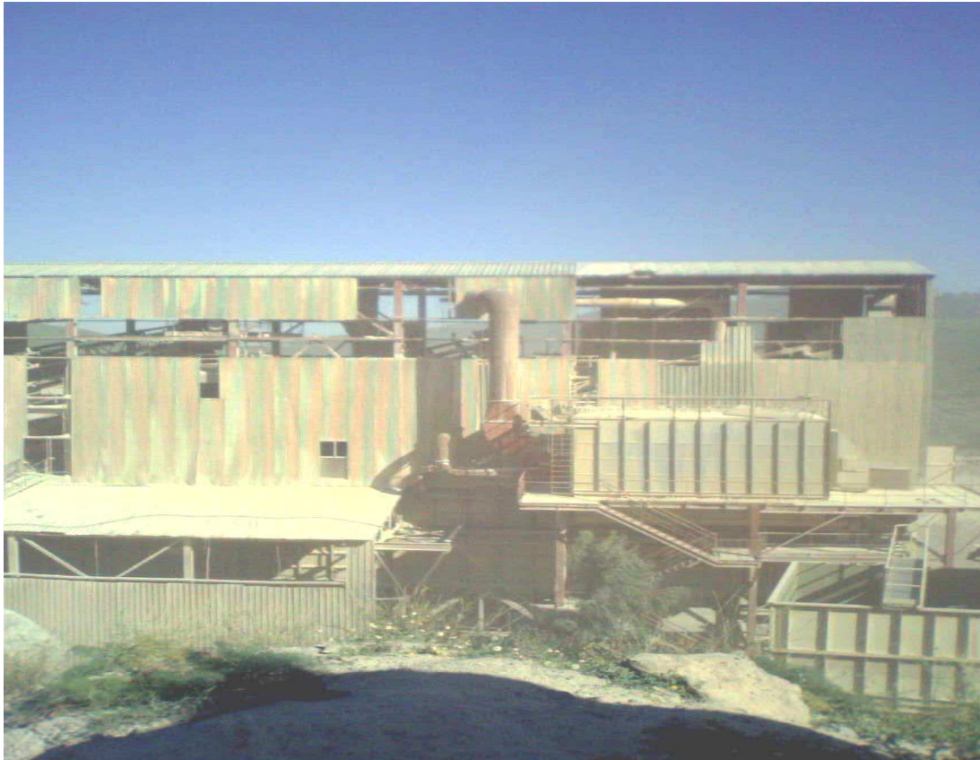
Figure3 : Les installations de l'atelier BABITLESS
