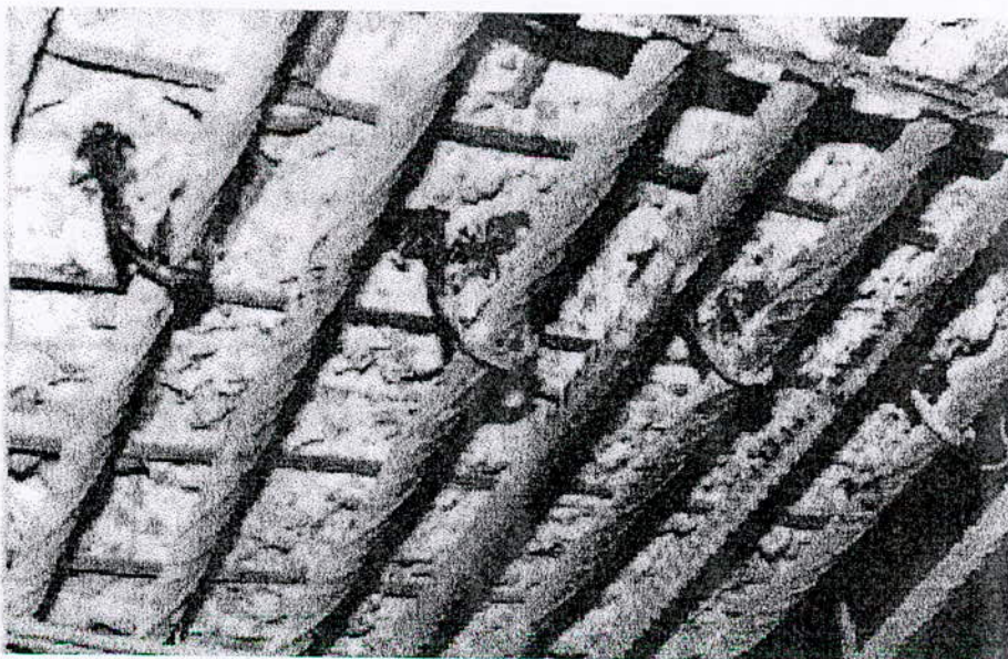
Fig : III-12 Armatures additionnelles de renforcement
